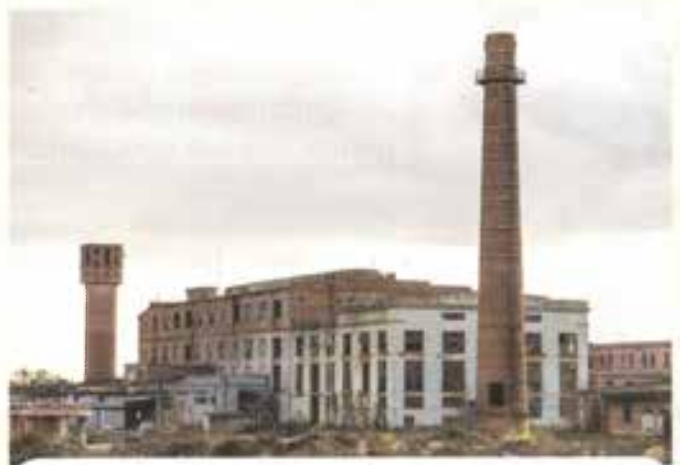
Полуразрушенное здание шебекинского химзавода
