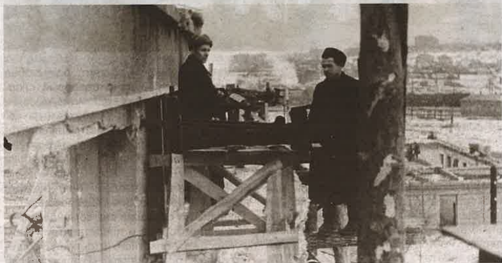
При помощи таких приспособлений выправляли стены повреждённых зданий и цехов, приводя их в вертикальное положение.
