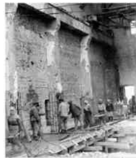
Деформированную стену котельной выправили гидравлическими домкратами за два рабочих дня.
