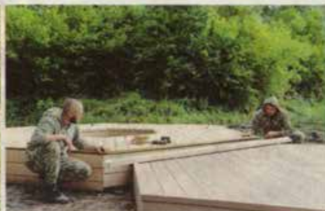
Рабочие укладывают деревянные соты
